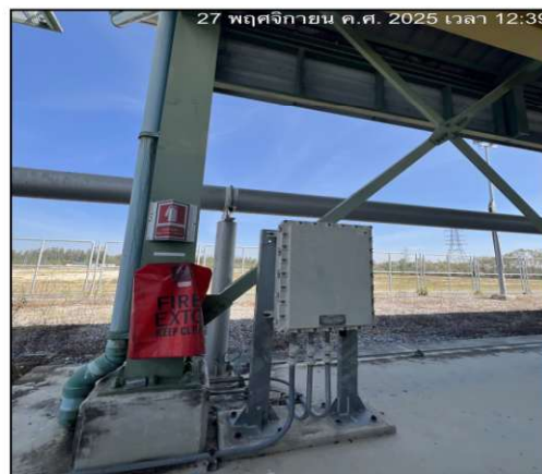
ติดตั้งเครื่องดับเพลิงแบบเคมีผงที่บริเวณสถานีวัดและควบคุมแรงดันก๊าซ (MRS)
